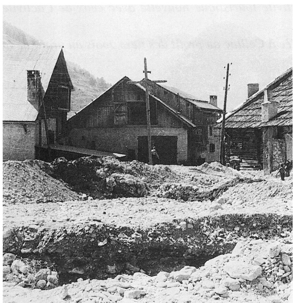
Ceillac après les inondations.
